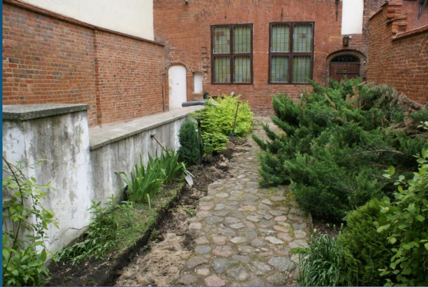
Stan zachowania przed pracami
