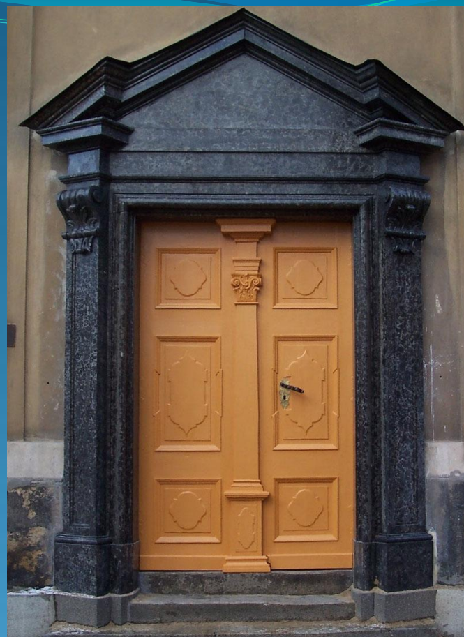
Portal po pracach konserwatorskich, południowa elewacja kościoła
