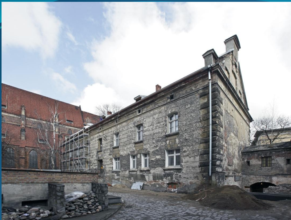
Stan zachowania przed pracami
