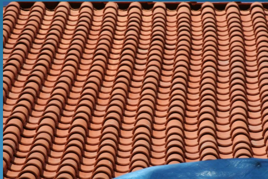
Widok na dach po wymianie pokrycia dachowego
