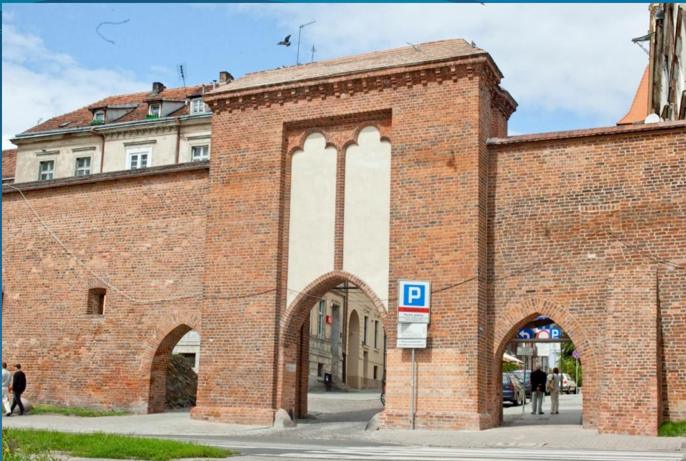
Fragment muru z Bramą Żeglarską po pracach konserwatorsko-remontowych
