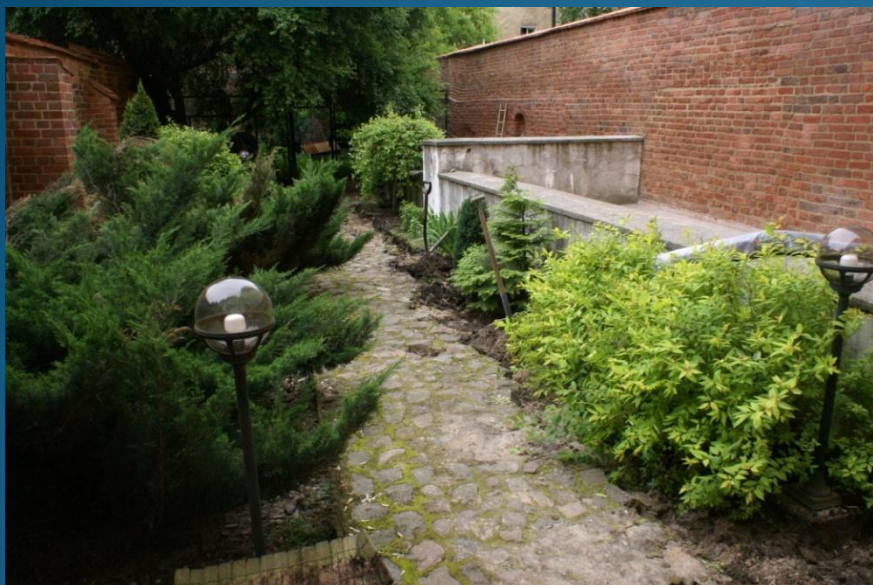
Stan zachowania przed pracami
