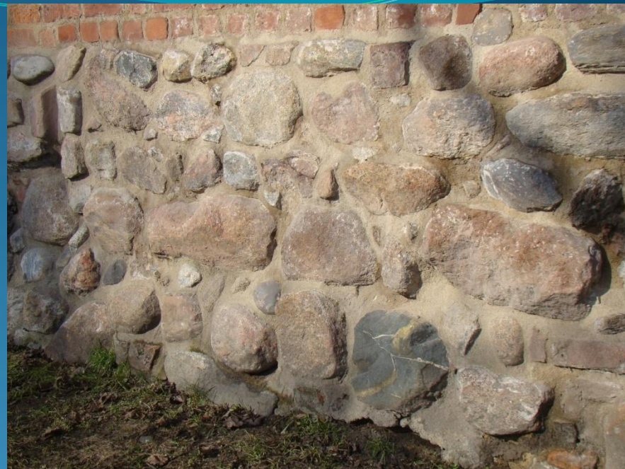
Mur po pracach konserwatorsko-remontowych, po oczyszczeniu i uzupełnieniu ubytków
