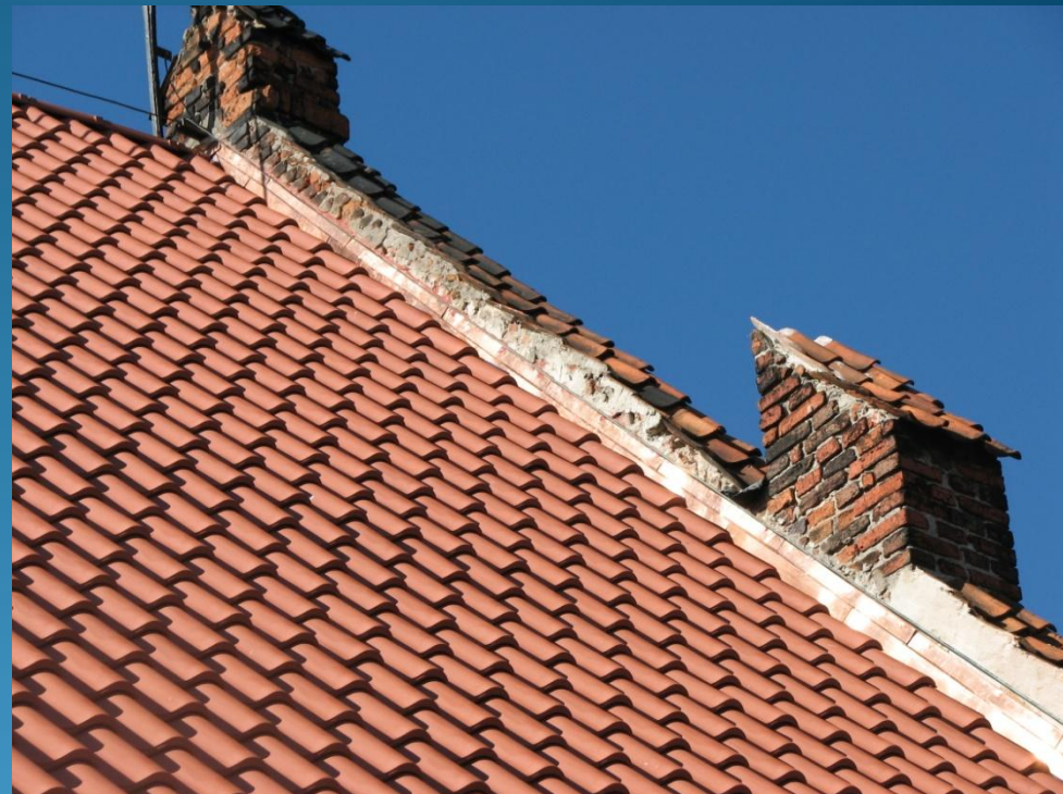
Widok na dach po wymianie pokrycia dachowego
