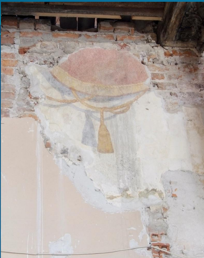
Prace restauratorskie przy zachowanych fragmentach polichromii ściennej
