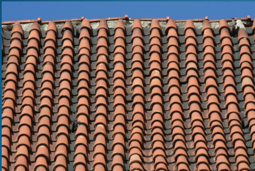
Widok na dach przed wymianą pokrycia dachowego
