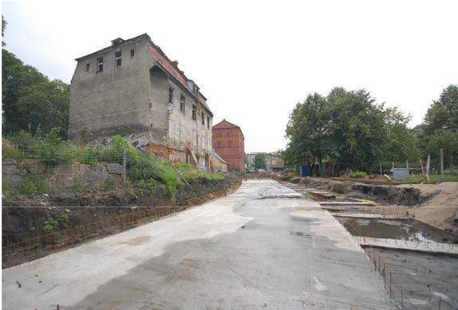
Budowa zespołu basenów parkowych – tzw. Międzywodzie – 2007 r.
