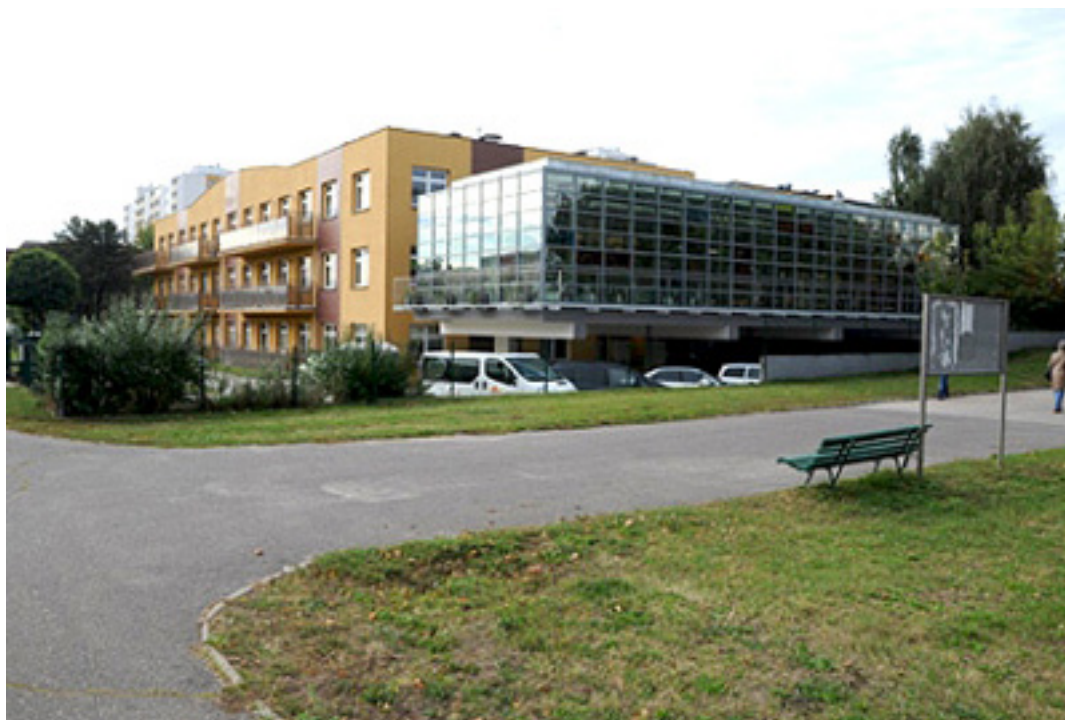
W Zakładzie Pielęgnacyjno-Opiekuńczym przy ul. Ligi Polskiej - modernizacja, rozbudowa i ogród zimowy
