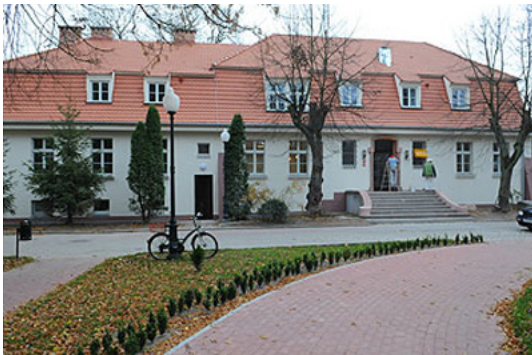
Miasto zmodernizowało także budynek „Prezydentówki” , w której działa Hospicjum „Światło”
